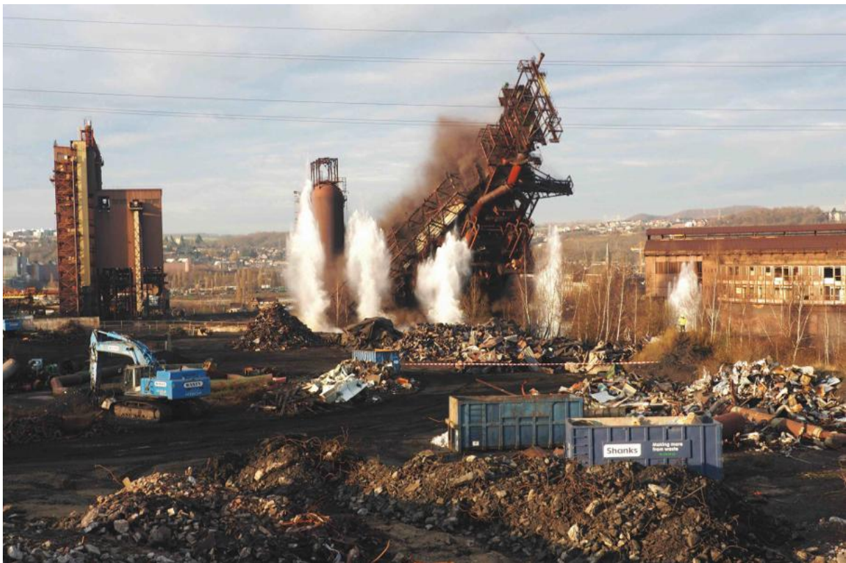
Dynamitage du haut-fourneau de Seraing
